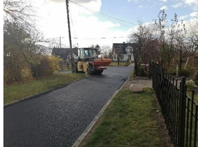
Rysunek 31. Zdjęcie z remontu ulicy Sobieskiego.
