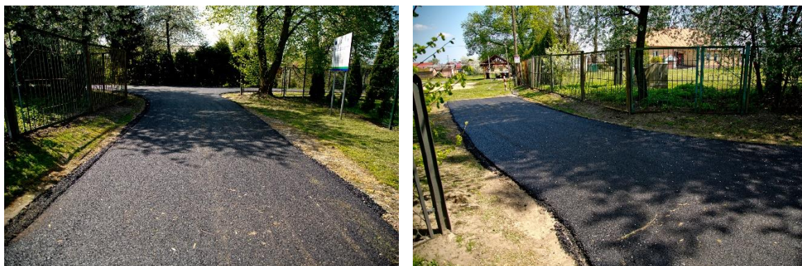
Rysunek 4. Remont ulicy Brzozowej oraz wjazdu na boisko – sołectwo Sławęcín.
