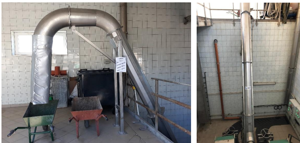
Rysunek 26. Przenośnik skratek na Oczyszczalni Ścieków.
