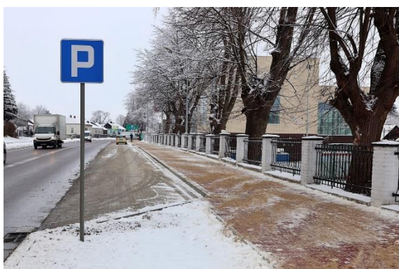
Rysunek 14. Budowa miejsc parkingowych przy ul. Żeromskiego.
